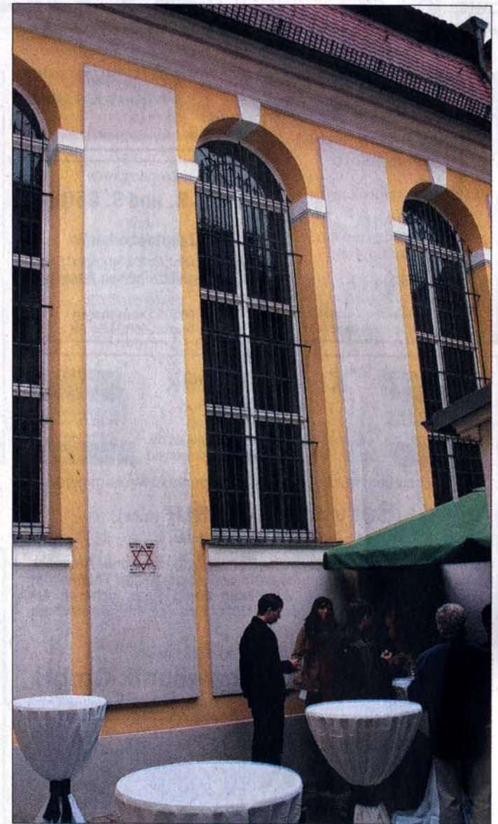
Der Innenhof der Ansbacher Synagoge.
