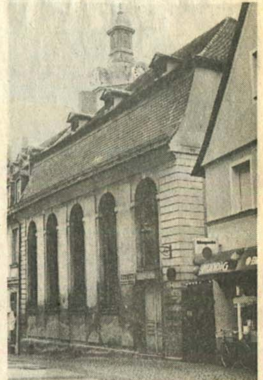
Äußerlich unscheinbar und trotzdem eine Kostbarkeit: Die erhalten gebliebene Ansbacher Synagoge. Die Zukunft des Retti-Baus in der Rosenbadstraße macht den Verantwortlichen weiter Kopfzerbrechen. Foto: Friedrich
