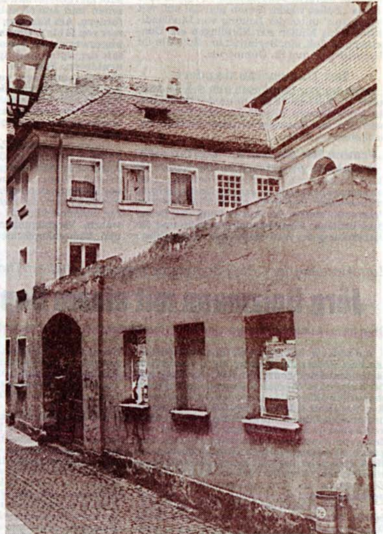
Der Synagogenkomplex von der Reuterstraße aus gesehen. In einem der Nebengebäude, dem Dienerhäuschen, ist ein Museum über die Geschichte der Juden in Ansbach geplant. Foto: Heubeck
